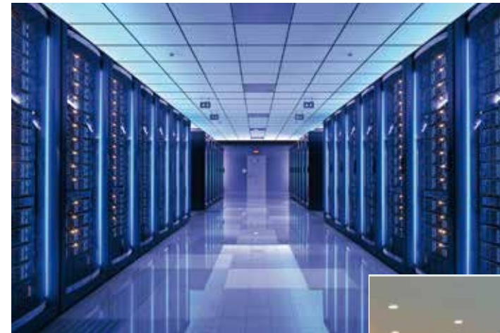
Rechenzentrum Uitikon Mit der Abwärme seiner Server und Switches beheizt es das Hallenbad der Gemeinde.
