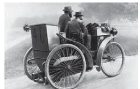
Edouard und André Michelin konstruierten 1895 den ersten Automobilpneu für das Rennen Paris–Bordeaux retour (1'200 km) für den Peugeot Type 3 (565 cm<sup>3</sup> Zweizylinder Benzinmotor mit 2 PS, 64 Wagen wurden total 1891-1894 produziert). Es waren 22 Reifenwechsel nötig.
